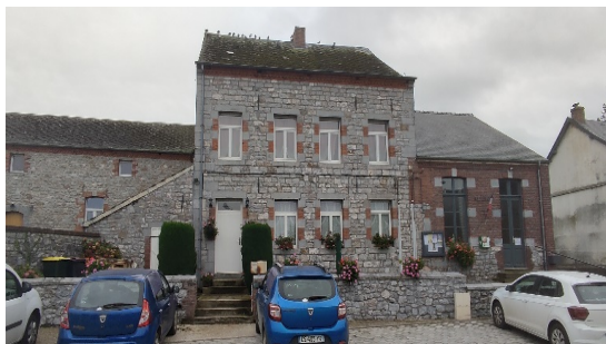
La maison à rénover est au centre de la photo
