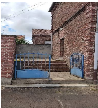
Devant l'entrée du futur logement
